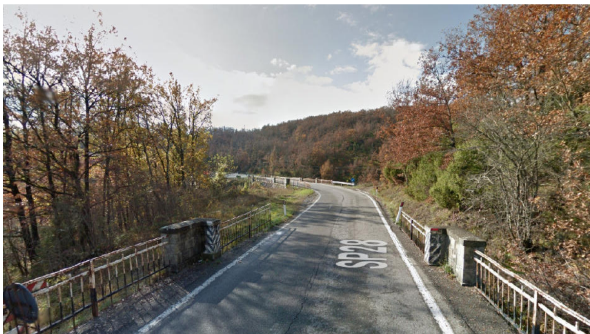
FIGURA 3 – PONTE SUL RIO CORSENNIA CIESABUONA LUNGO SP28 DI VARSÌ IN LOC. CAVALLARA (DIR. BARDI)
