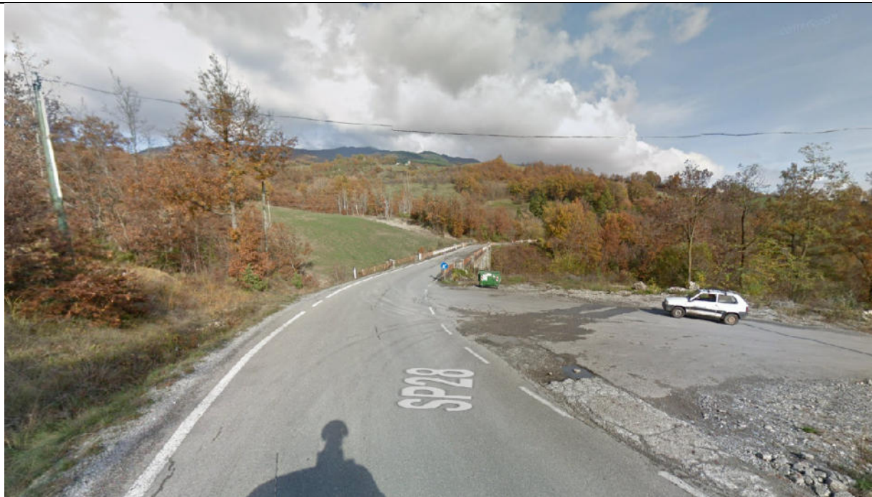
FIGURA 6 – PONTE SUL TORRENTE CORSENNIA DEI BERTONAZZI LUNGO SP28 DI VARSÌ IN LOC. CAVALLARA (DIR. VARSÌ)
