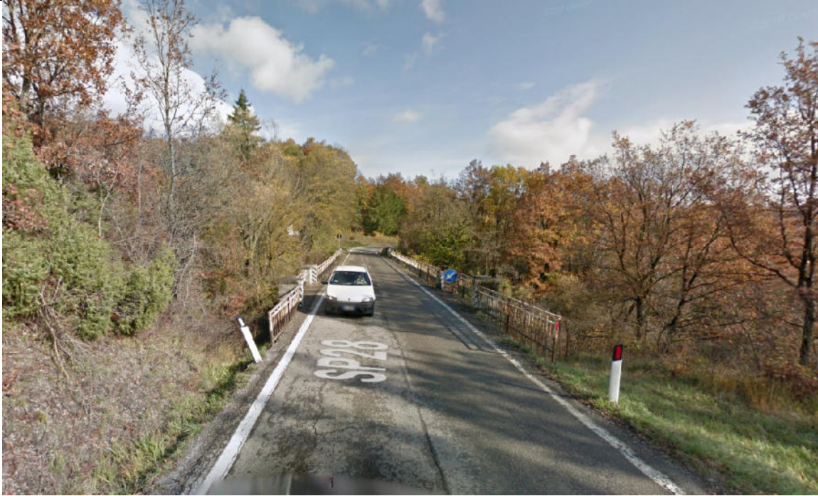
FIGURA 8 – PONTE SUL RIO CORSENNA CHIESABUONA LUNGO SP28 DI VARSÌ IN LOC. CAVALLARA (DIR. VARSÌ)
