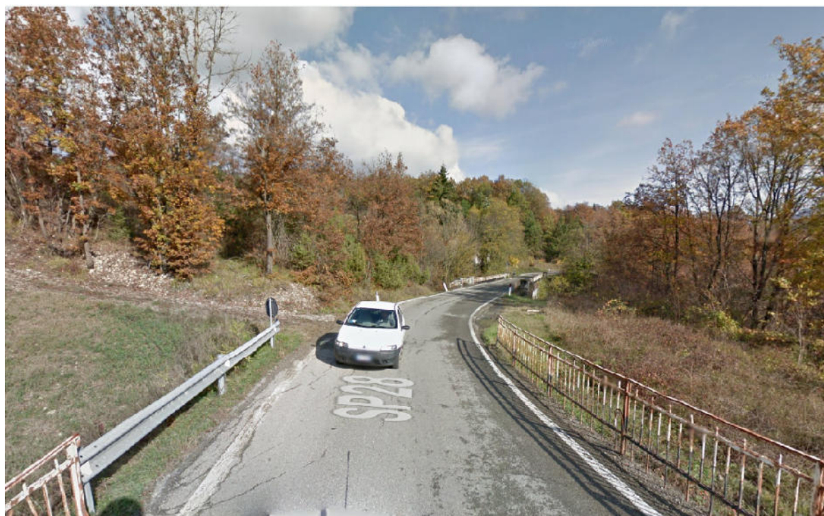
FIGURA 7 – PONTE SUL TORRENTE CORSENNIA DEI BERTONAZZI E PONTE SUL RIO CORSENNIA CHIESABUONA LUNGO SP28 DI VARSÌ IN LOC. CAVALLARA (DIR. VARSÌ)
