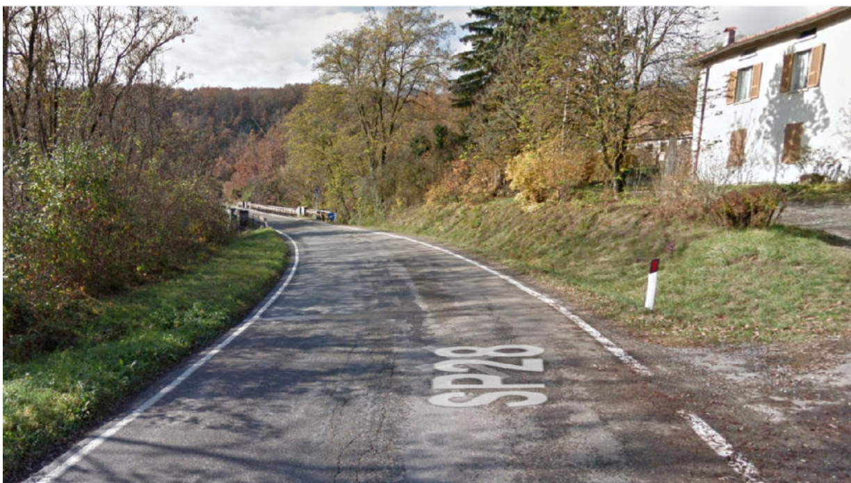
FIGURA 2 – PONTE SUL RIO CORSENNIA CIESABUONA LUNGO SP28 DI VARSÌ IN LOC. CAVALLARA (INGRESSO DA VARSÌ)
