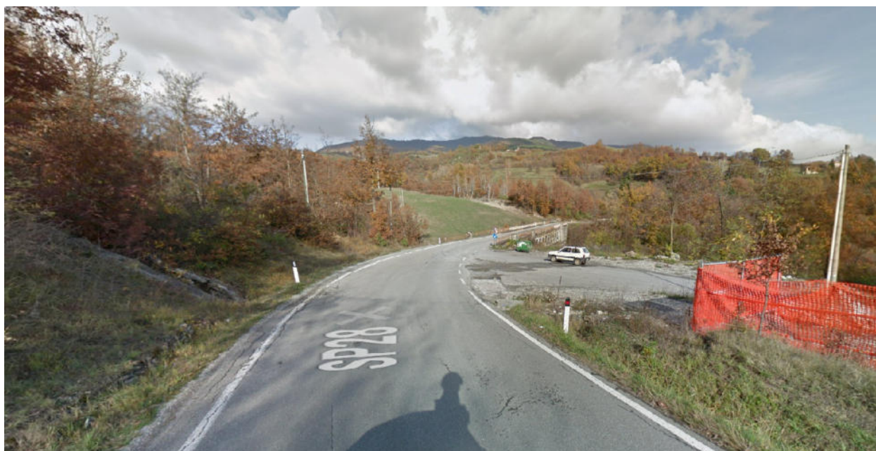
FIGURA 5 – PONTE SUL TORRENTE CORSENNIA DEI BERTONAZZI LUNGO SP28 DI VARSÌ IN LOC. CAVALLARA (DIR. VARSÌ)
