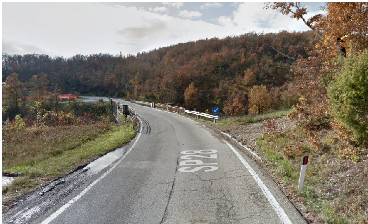
FIGURA 4 – PONTE SUL TORRENTE CORSENNIA DEI BERTONAZZI LUNGO SP28 DI VARSÌ IN LOC. CAVALLARA (DIR. BARDI)
