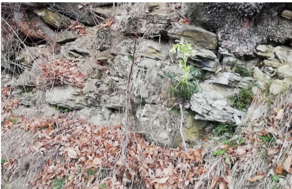
FIGURA 4-1– AFFIORAMENTO DI UN LIVELLO CALCARENITICO DEL FLYSCH DI MONTE CAIO POCO A MONTE DEL PRIMO TRATTO D'INTERVENTO
