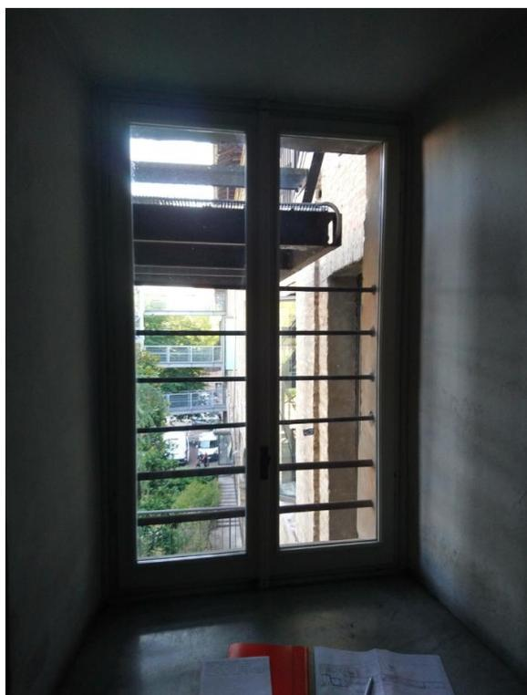
Lungo la scala sud, tra i piani primo e secondo, è presente una finestra di larghezza 135cm ed altezza 200cm in affaccio diretto sulla scala di sicurezza esterna via di esodo. Al fine di garantire la sicurezza degli occupanti in caso di esodo sulla scala esterna, si prevede la fornitura e posa in opera di una tenda tagliafumo E60 W20, con cassone 200x200mm, larghezza 1410mm ed altezza 2040mm.
