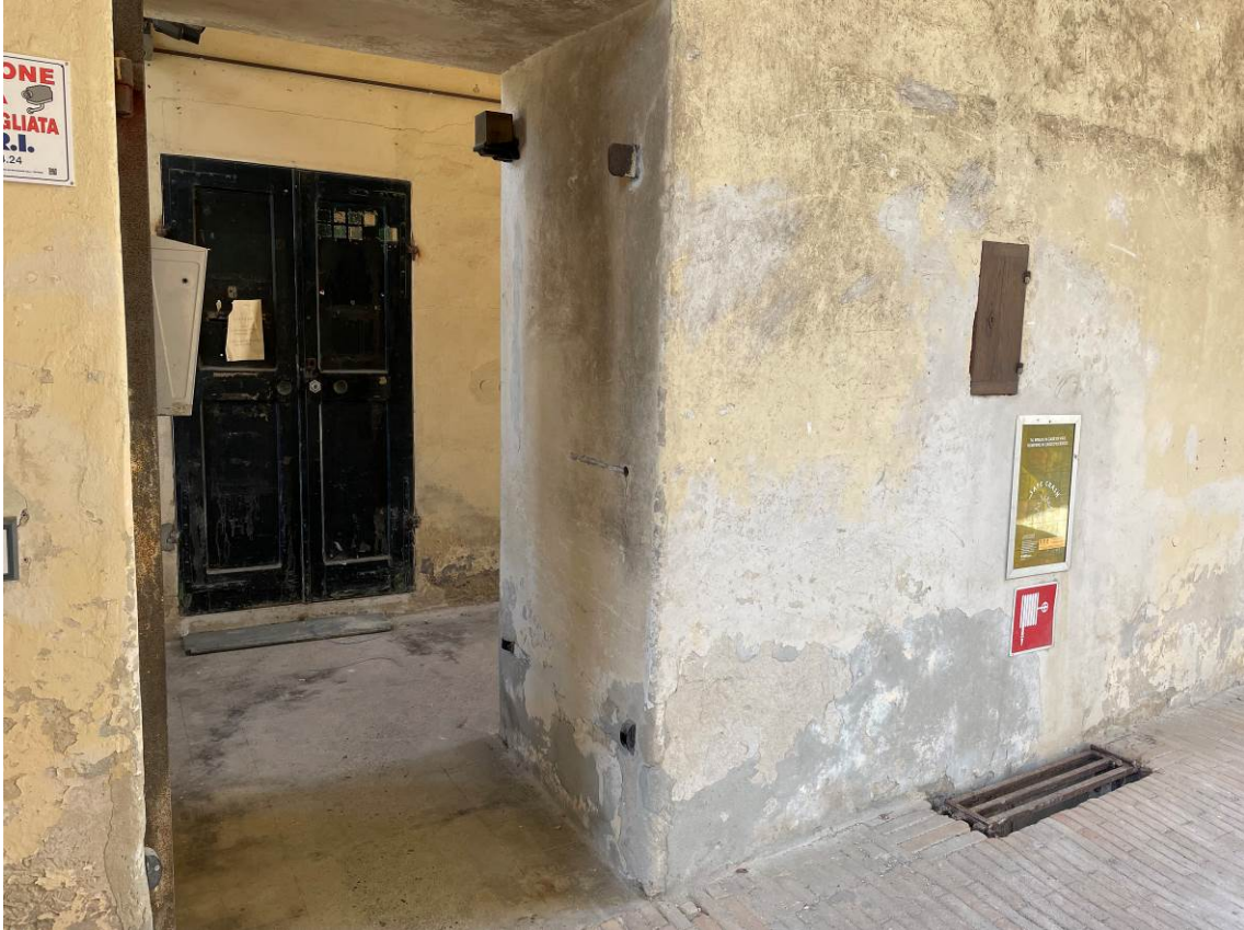
INGRESSO LOCALI EX-PROLOCO
