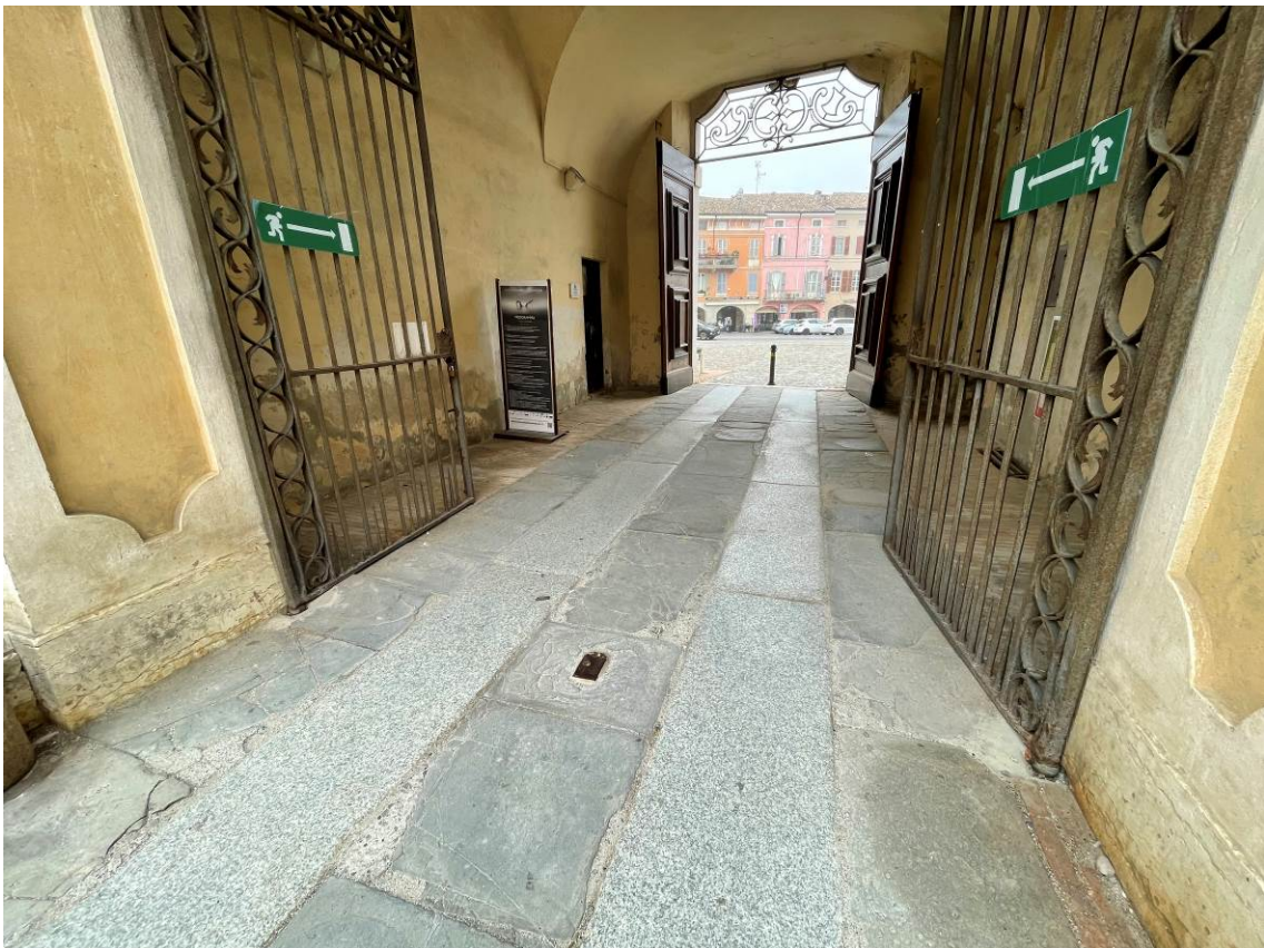
VISTA SU PAVIMENTAZIONE
