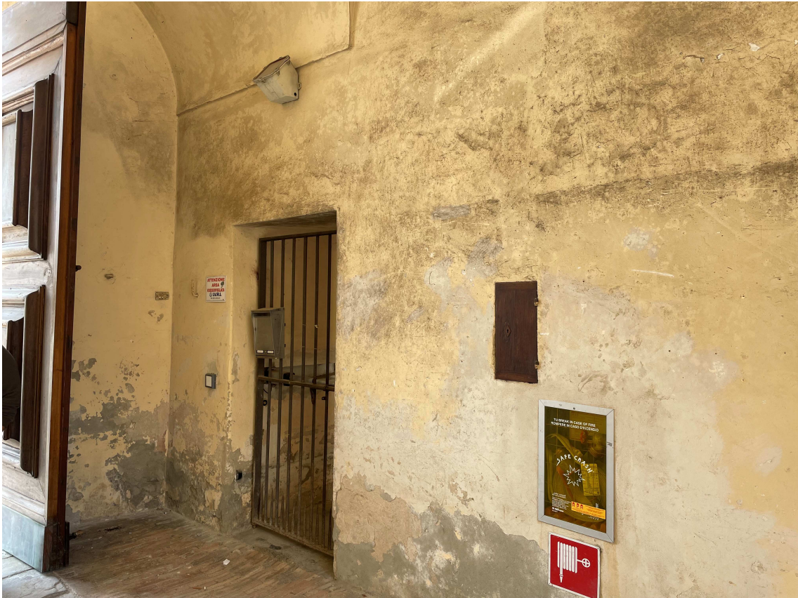
PARETE LATO LOCALI EX-PROLOCO
