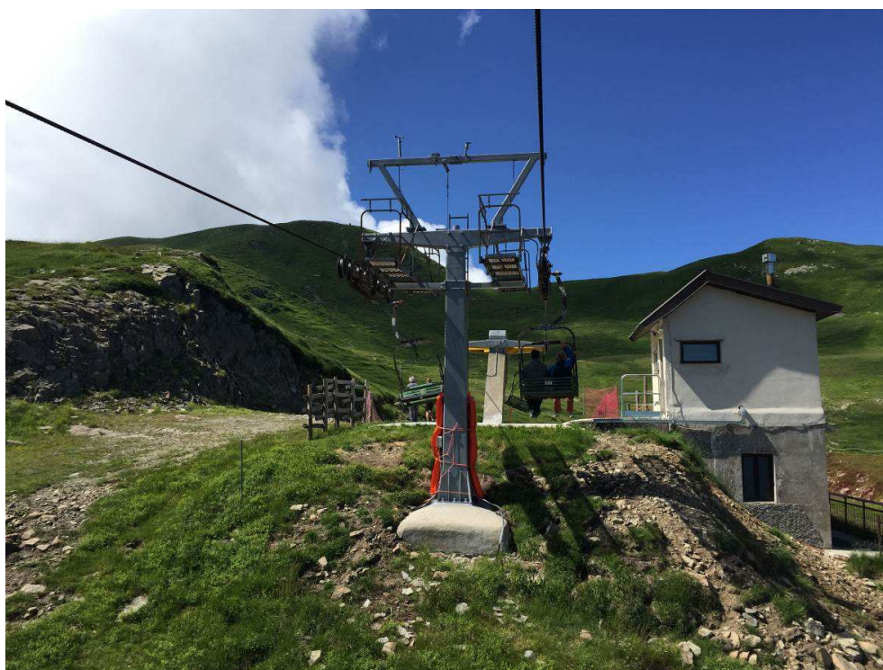
seggiovia Prato Spilla – Rio Spilla: linea verso monte
