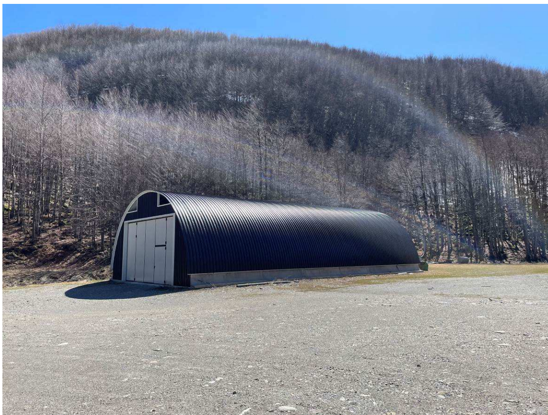
deposito esterno - hangar
