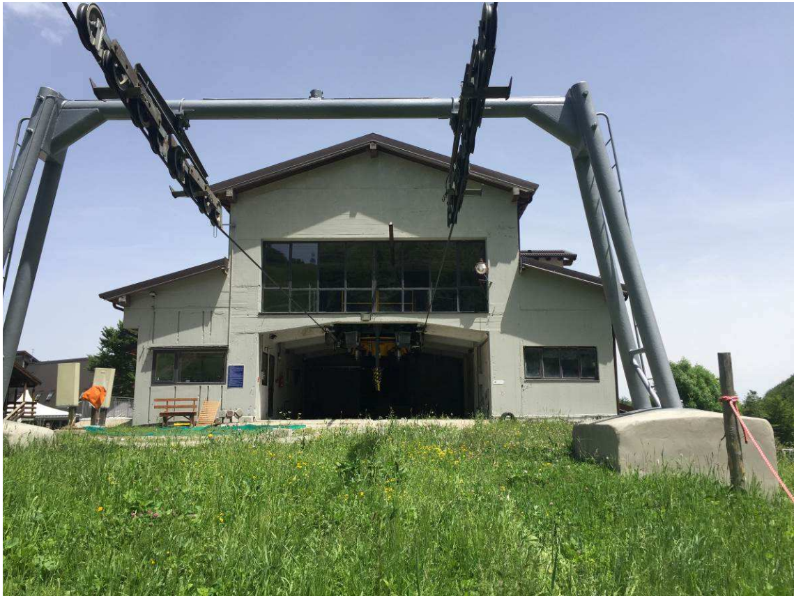
stazione di partenza – prospetto sud (vista su seggiovia)
