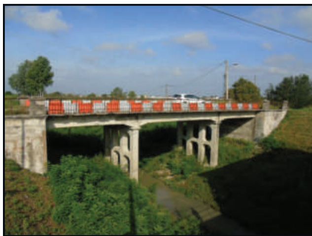
Fig. 3. - Vista ponte da valle verso monte
