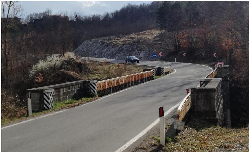
Per la lunghezza della nuova soletta, circa 30 metri, saranno posate barriere tipo H2 bordo ponte, queste saranno prolungate con barriere tipo H2 bordo laterale infisse nel terreno nella seguente misura:
