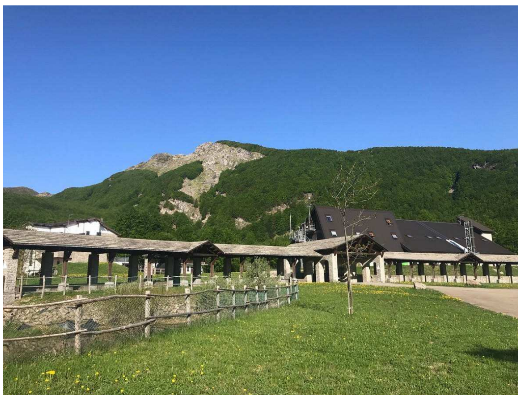
Vista porticato esterno
