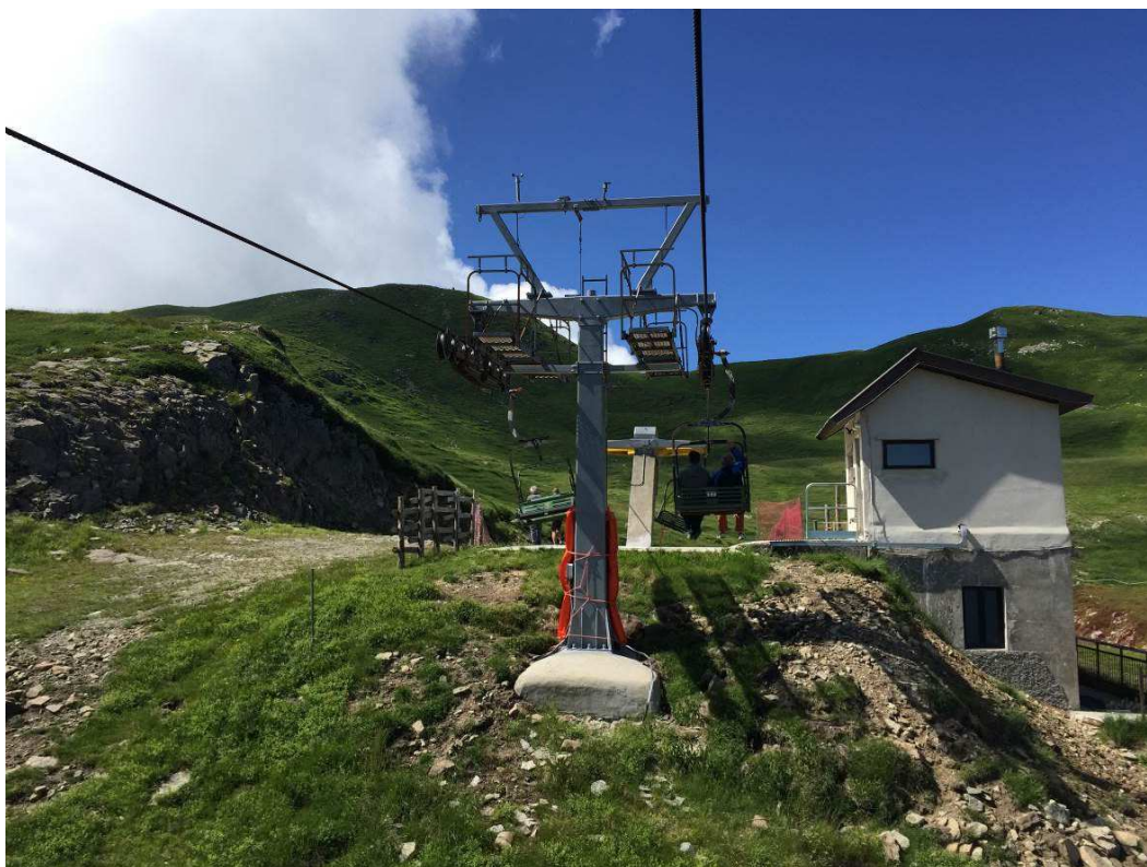
Seggiovia Prato Spilla – Rio Spilla: linea verso monte – stazione di arrivo
