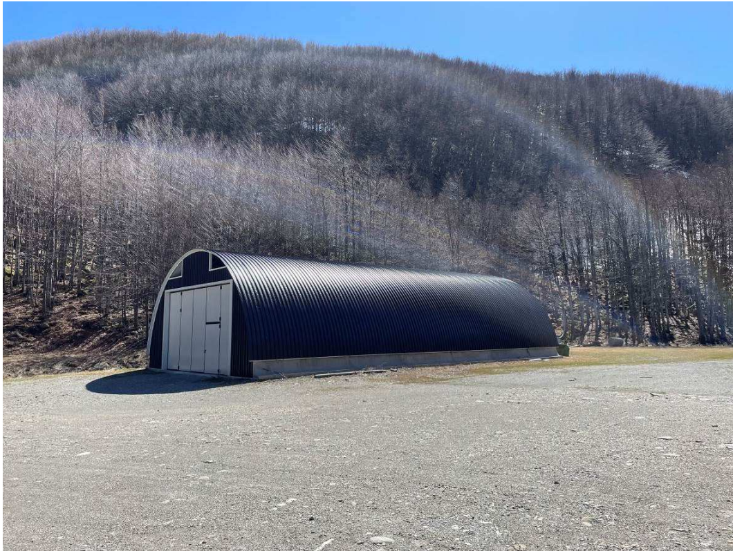
Deposito esterno - hangar
