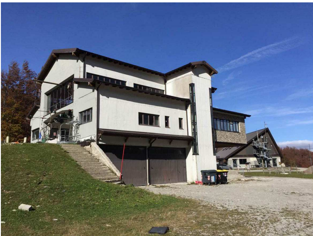
Seggiovia Prato Spilla – Rio Spilla: linea verso monte – stazione di partenza: prospetto sud- est
