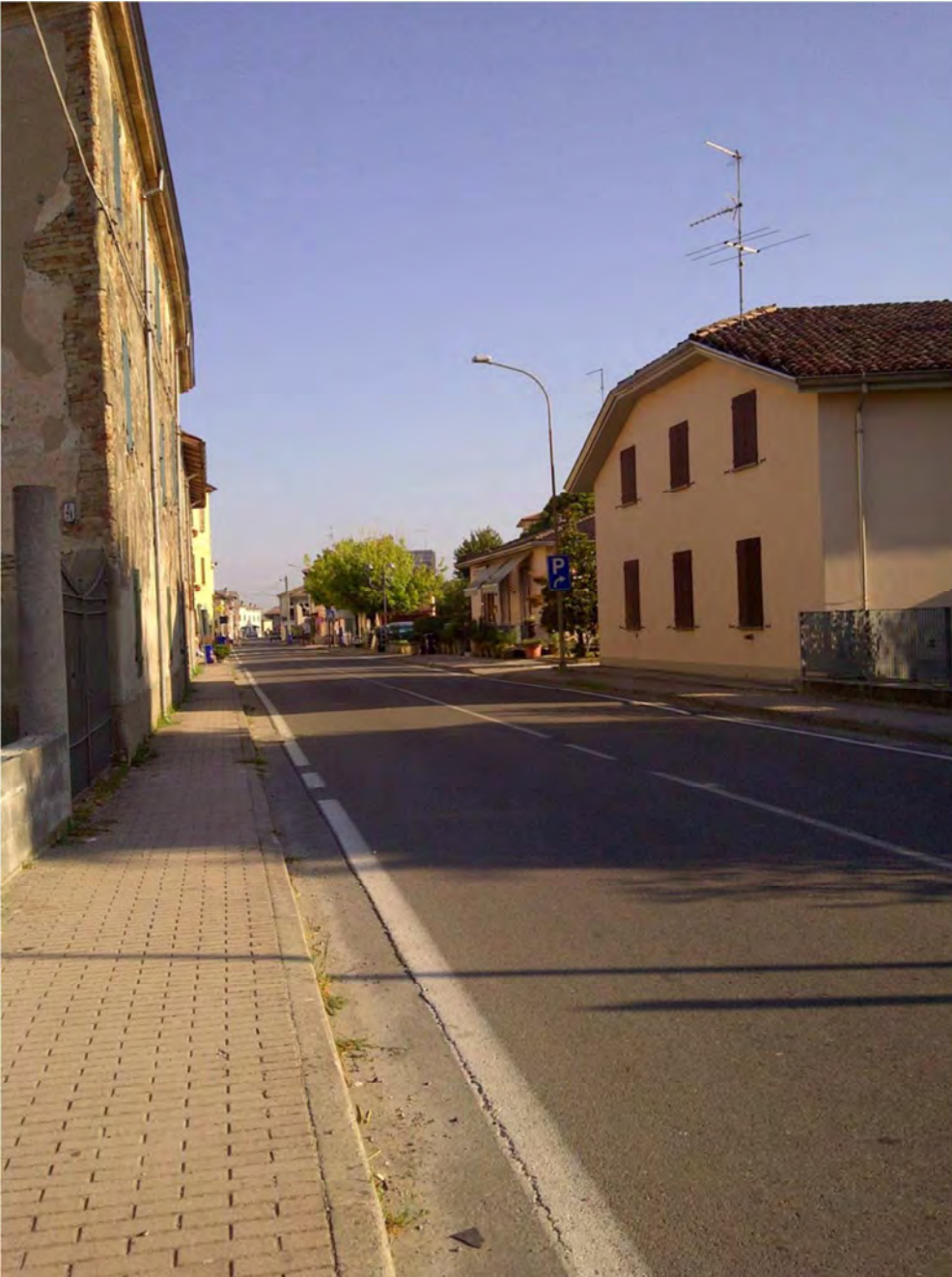
Via Roma, marciapiedi esistenti nella parte centrale dell'abitato
