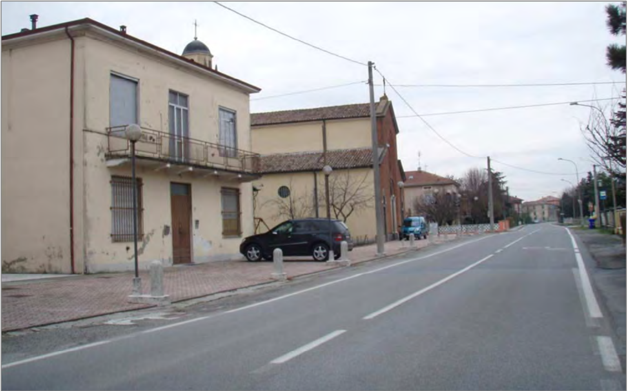
Via Roma, zona pavimentata esistente
