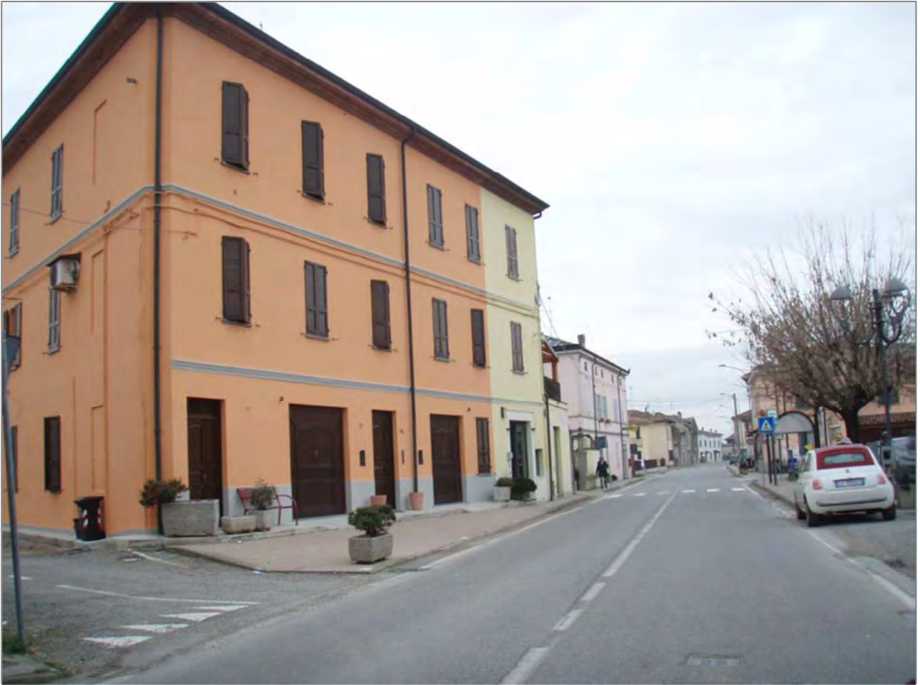
Via Roma, tratto con marciapiedi esistenti
