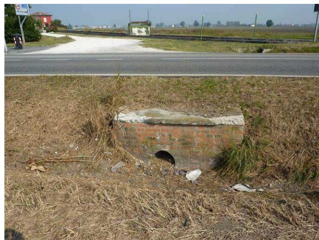
FIGURA 6-11 – MANUFATTO DI SBOCO DEL TOMBINO DI SCARICO DELLE ACQUE DI PIATTAFORMA NEL FOSSO OVEST DI STRADA PROVINCIALE 11
