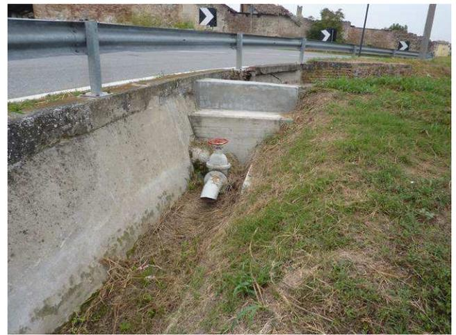
**FIGURA 6-9 – ORGANO DI REGOLAZIONE DEL MANUFATTO DI PRESA IRRIGUA SUL CANALE NUOVO CANALE**
