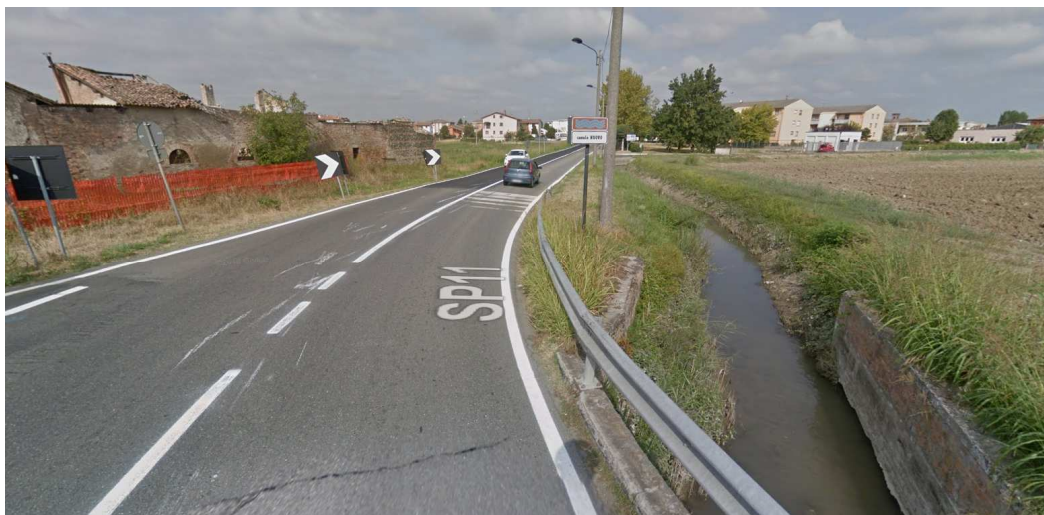
FIGURA 2-10 –S.P. N° 11 NEL TRATTO IN CORRISPONDENZA DELL'INTERSEZIONE CON STRADA DEL TORCHIO
