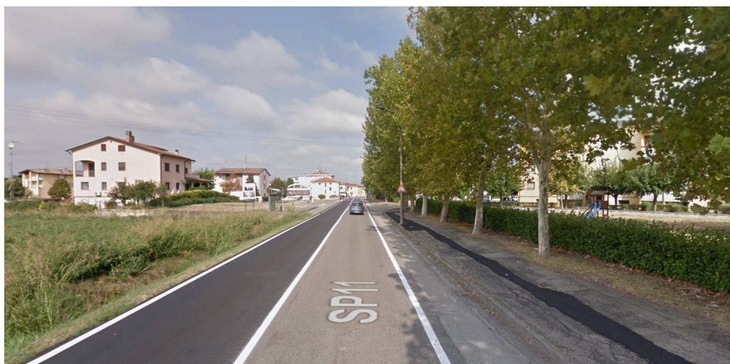
FIGURA 2-11 –S.P. N° 11 NEL TRATTO AD OVEST DELL'INTERSEZIONE
