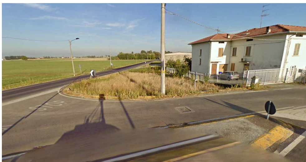
FIGURA 2-13 – STRADA DEL TORCHIO NEL TRATTO PROSSIMO ALL'INTERSEZIONE
