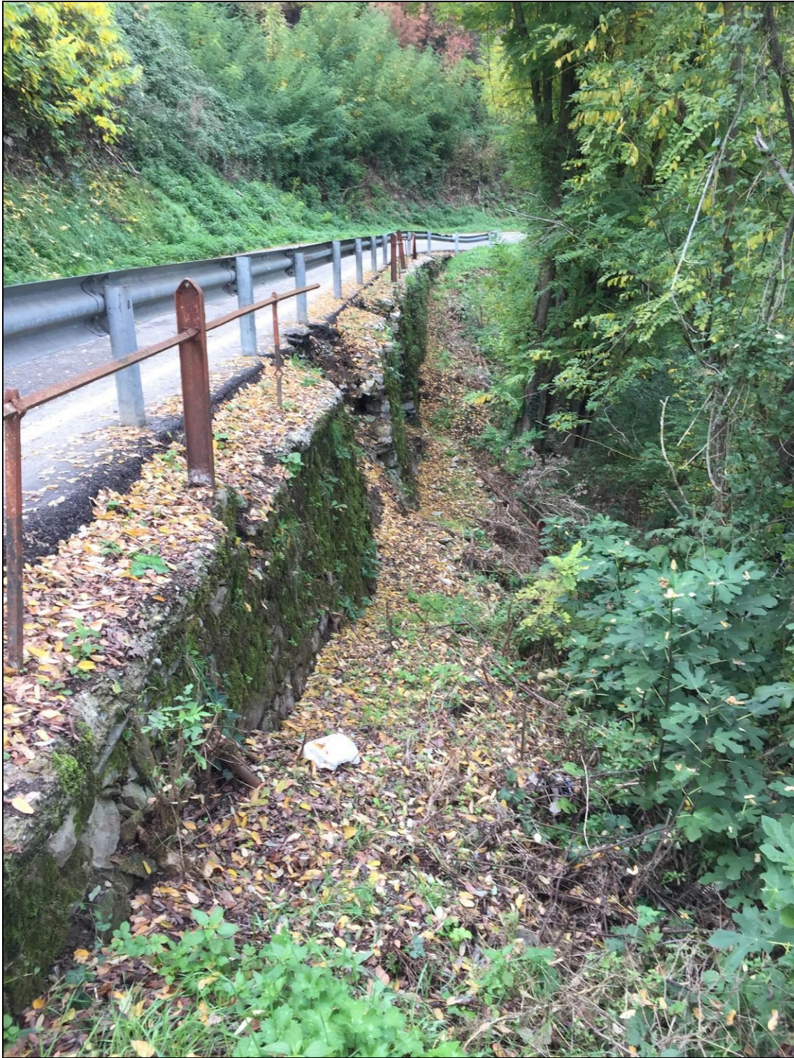
Figura 5 – Muro di sottoscarpa (manufatto 2): vista laterale di una porzione
