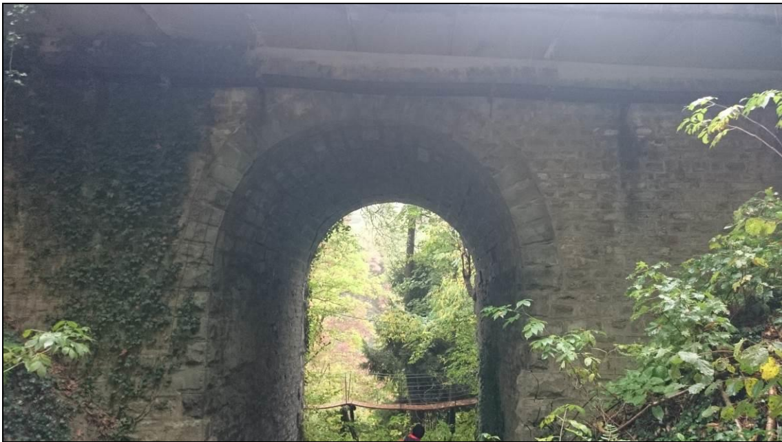
Figura 2 – Vista laterale del manufatto da lato monte
