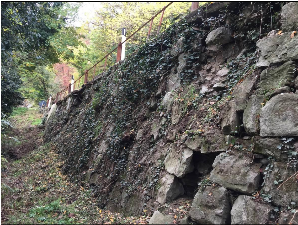
Figura 4 – Muro di sottoscarpa (manufatto 1): vista laterale di una porzione
