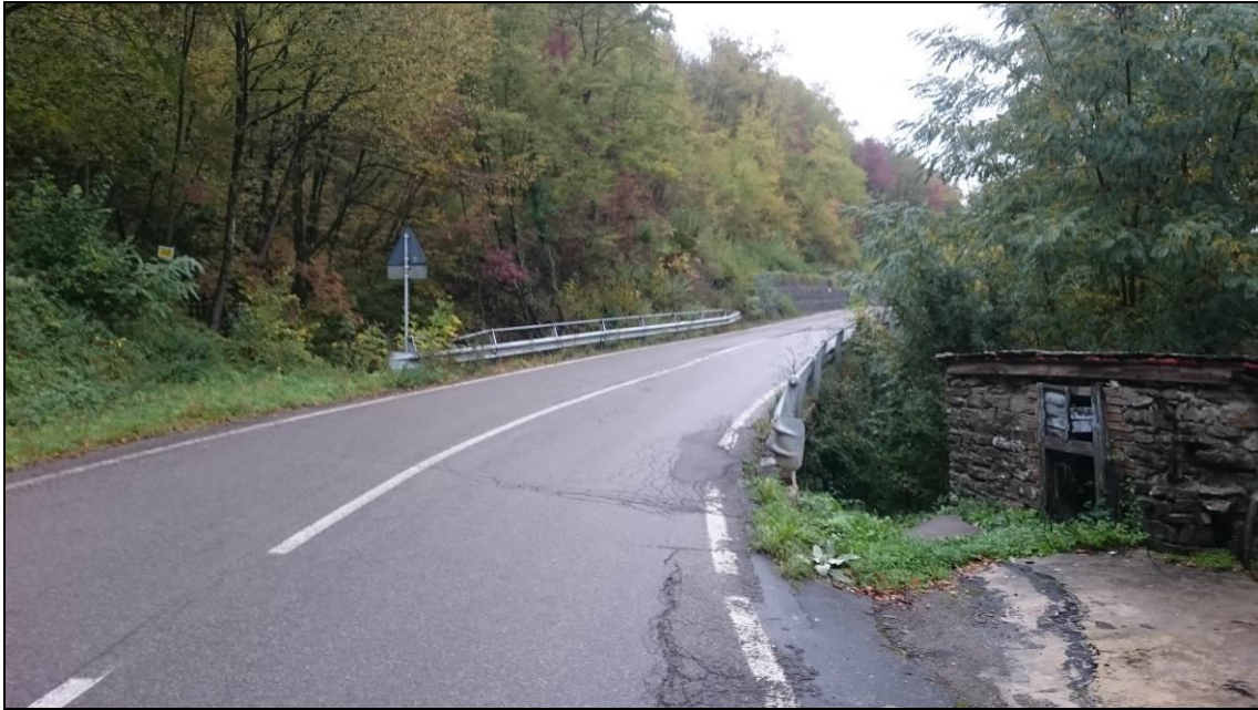
Figura 1 – Vista del manufatto dalla piattaforma stradale (lato Ponte Bratica)
