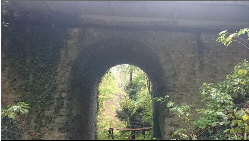
Figura 2 – Vista laterale del manufatto da lato monte
