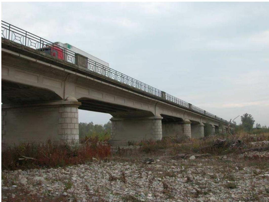
Lo schema statico di progetto prevede un totale di 6 travate continue; le due estreme sono a due campate su tre appoggi (campata esterna da 17.40m, interna da 18.45m), mentre le quattro interne sono a tre campate su quattro appoggi ciascuna (campate esterne da 18.40, campata interna da 20.00m), per un totale appunto di 16 campate.
