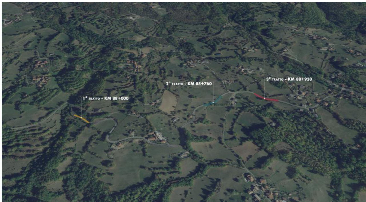
FIGURA 2-5– IMMAGINE DEL CONTESTO PAESAGGISTICO DI RIFERIMENTO CON EVIDENZIATA LA POSIZIONE DEI TRATTI OGGETTO DI INTERVENTO
