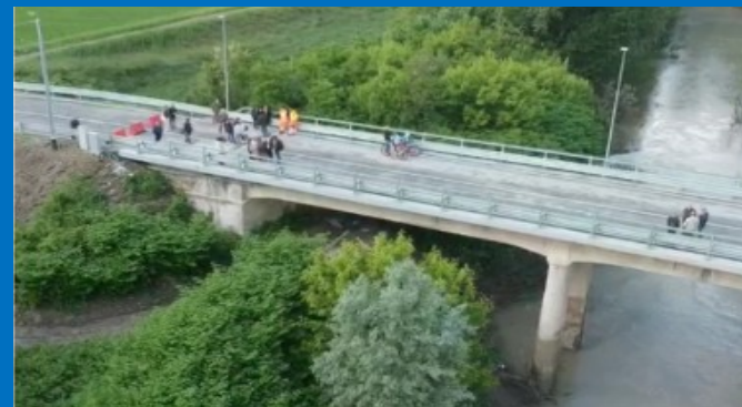
Riapertura del Ponte di San Siro dopo importanti lavori di rifacimento
