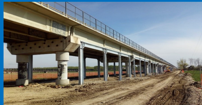
Lavori di rifacimento urgenti al Ponte sul Po a Colorno – Casalmaggiore
